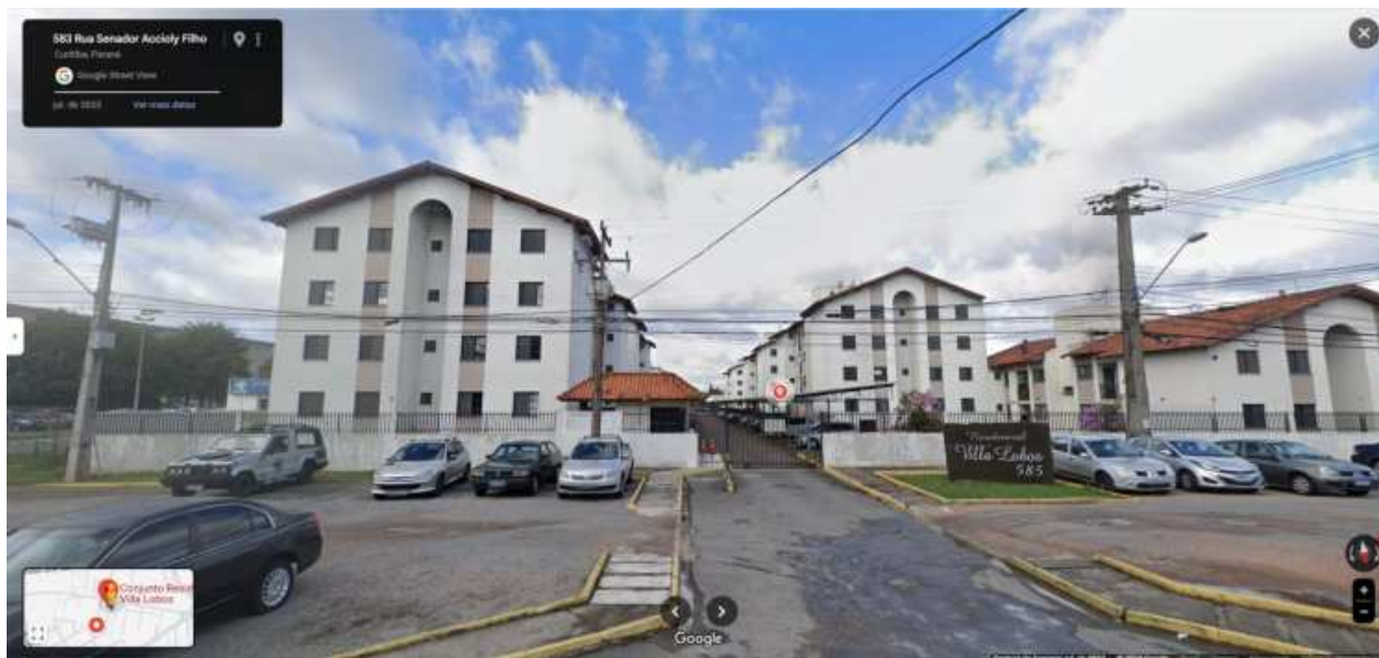
Vista do Imóvel Avaliando
